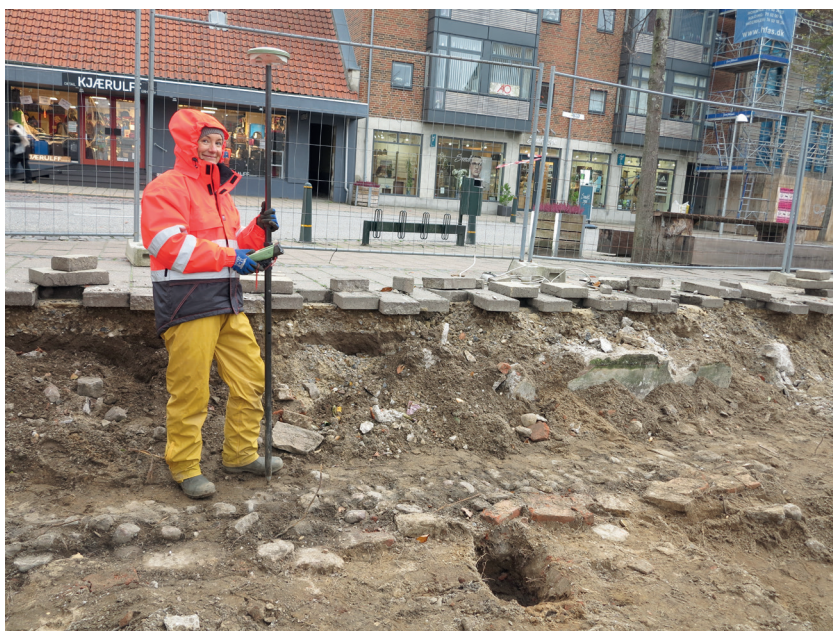
Opmåling af fundamenter. Her ses både kampestensfundamentet og teglstensfodremmen til Munkekroens facade. Louise står på pigstensbelægning foran Munkekroen.
